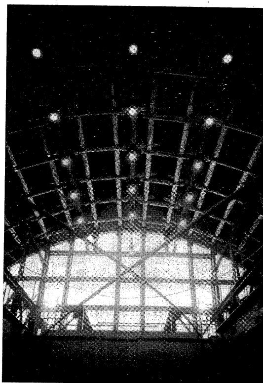
内部見上：間口7間奥行9間の丸太組による変形トラスによるアーチ構造
